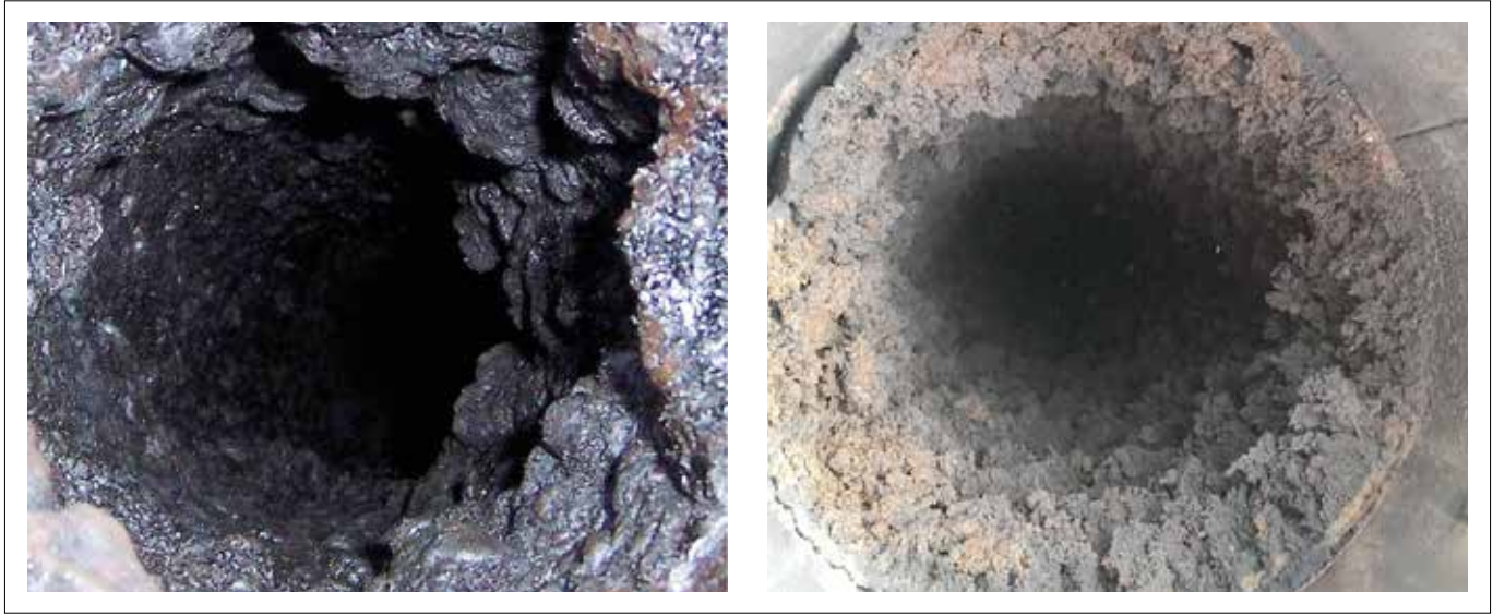
Şekil 2. Baca İçinde Oluşan Kreozotun Görüntüsü
